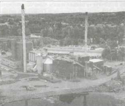
Şekil 2: Finlandiya'da odun yakarak elektrik üreten santral.
